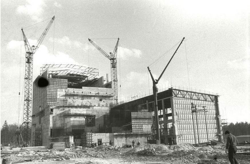
Bild 50. Kernkraftwerk Rheinsberg, Aufbau erster Block, dessen Errichtung schon 1956 beschlossen wurde, nachdem das erste Kernkraftwerk der Welt in England gerade in Betrieb gegangen war. Der Bau des zweiten, von Steenbeck initiierten Blockes ist nie begonnen worden. Steenbeck leitete von 1957 bis 1960 das Büro für Reaktorbau in Berlin. Danach war er bis 1962 Werkdirektor des VEB Entwicklung und Projektierung kerntechnischer Anlagen. Leistungen: 70 MW elektrisch, 265 MW thermisch. Quelle: EWN GmbH.
