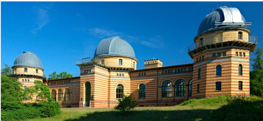
Bild 13. Hauptgebäude (Südseite) des Astrophysikalischen Observatoriums. Die Backsteine stammen aus regionalen Ziegeleien, Grundmauern und Treppen aus Sandstein von Wefensleben und die Verkleidung aus Siegersdorf bei Bunzlau. Mittelskuppel 10 m. Oben: Originalzustand mit eingebautem Heliograph; unten: mit nachträglich geschaffenem Südgang sowie verglasten Wandelgängen. Photos: Architekturmuseum Berlin, R. Arlt.
