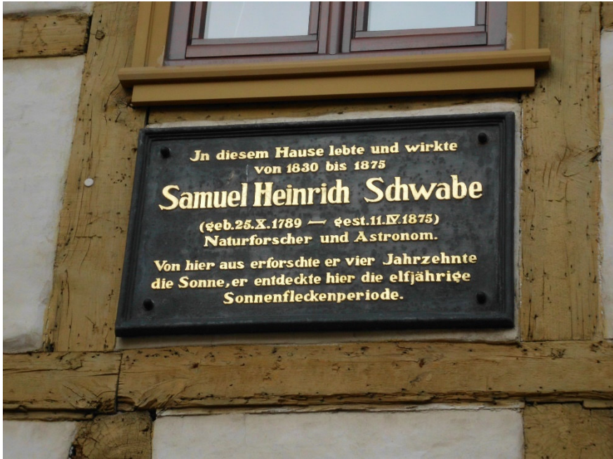
Bild 4. Dachastronomie mit ungeahnten Folgen (Dessau, Johannisstraße 18).
