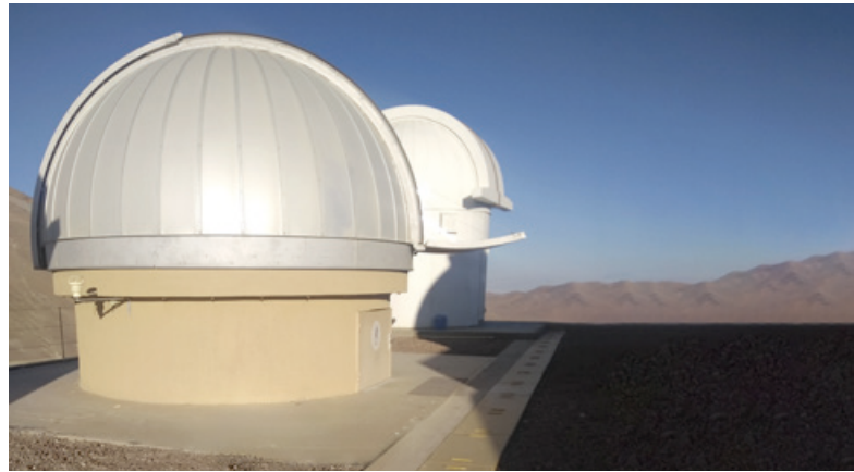
Sonnenuntergang am Cerro Murphy Observatorium. Im Vordergrund die Kuppel der BMK10k kurz vorm Öffnen, damit die Tageshitze entweicht und ein Temperaturgleichgewicht zur Umgebung hergestellt wird.
