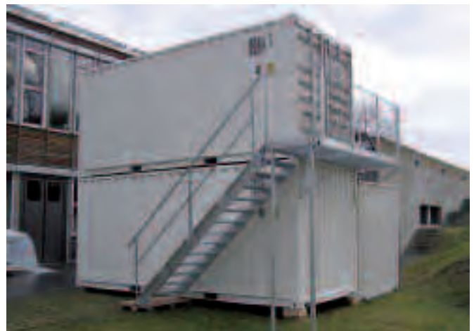
Das PEPSI Kontrollzentrum während des Aufbaus am Standort
