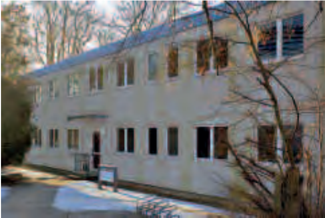
Container: Das Bürogebäude neben der Bibliothek wird von den Arbeitsgruppen Solare Radioastronomie und Kosmologie genutzt.
